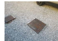
Superficie non pavimentata
