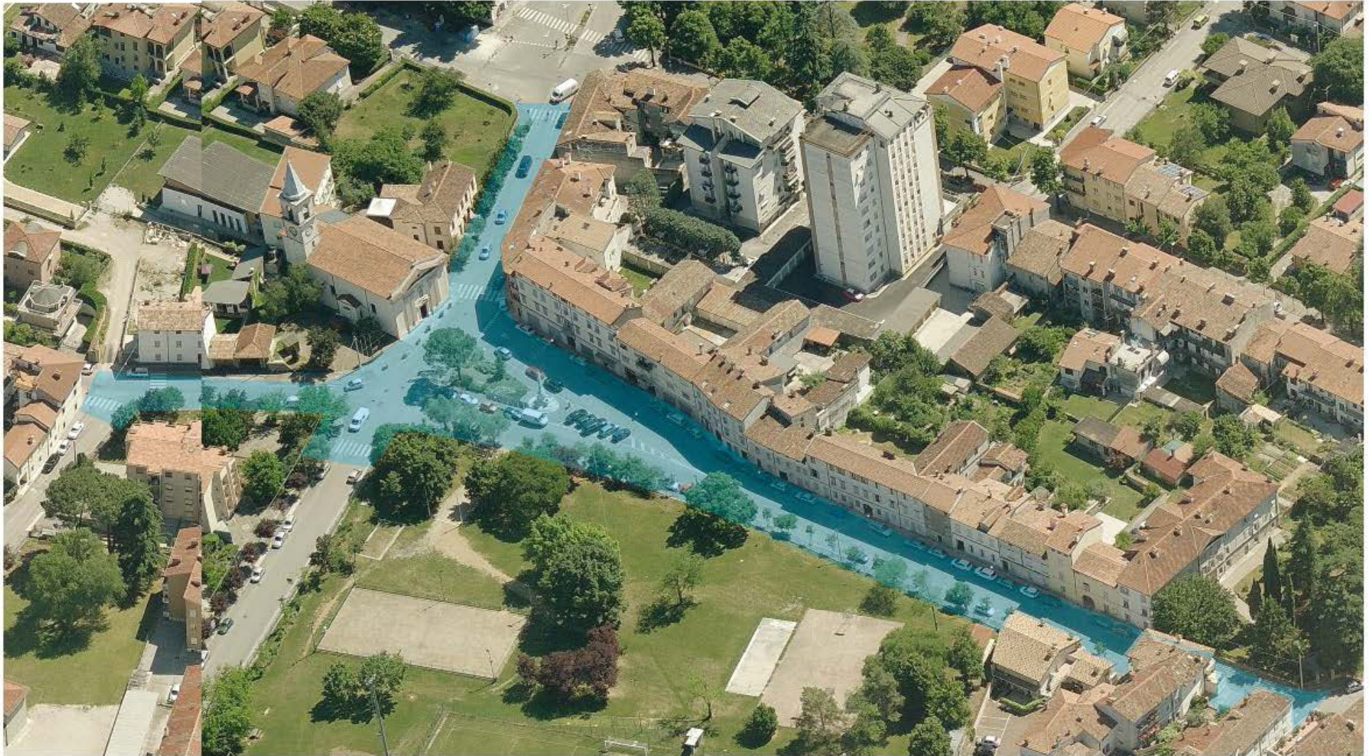
Vista aerea dell'area d'intervento relativa a Piazza San Rocco.
